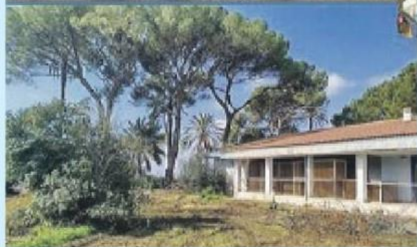
La consegna dei lavori
